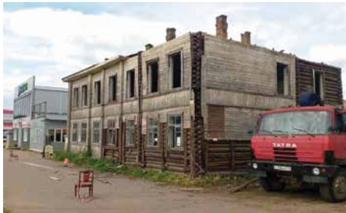
Снос аварийных зданий в городе Окуловка
