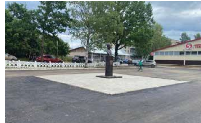
Благоустройство территории Окуловского городского поселения
